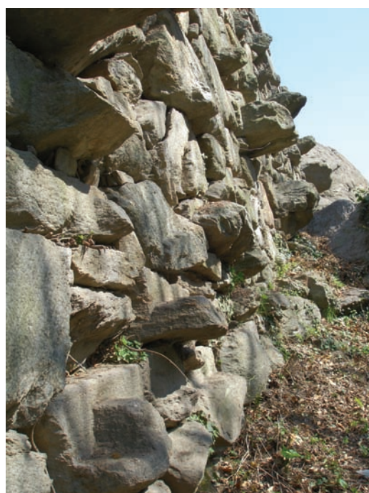
14. Détail du parement en maçonnerie bossagé. (M. Cortelazzo)
