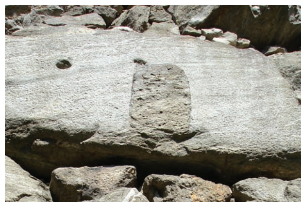
15. Détails de bossages brisés. (M. Cortelazzo)
