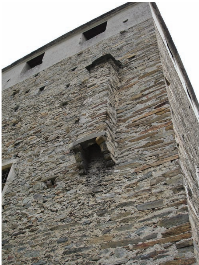
7. Latrina aggettante del torrione. (M. Cortelazzo)
