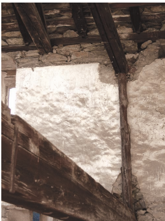
10. Particolare di una tramezzatura lignea, di cui rimangono travi e montanti, al piano del camino. (S.E. Zanelli)
