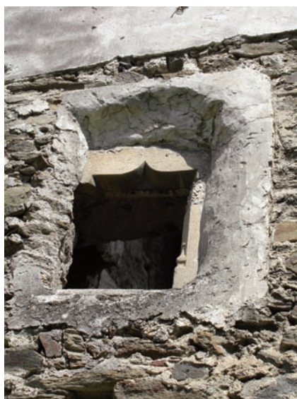
15. Finestra sulla fronte sud, con architrave a chiglia rovesciata. (S.E. Zanelli)
