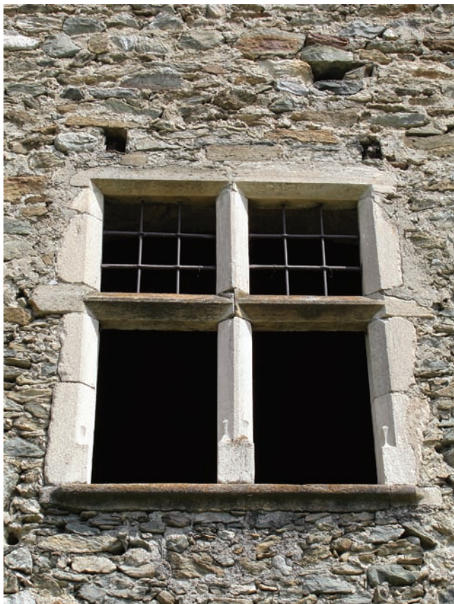
12. La finestra crociata sulla fronte ovest del torrione. (S.E. Zanelli)
