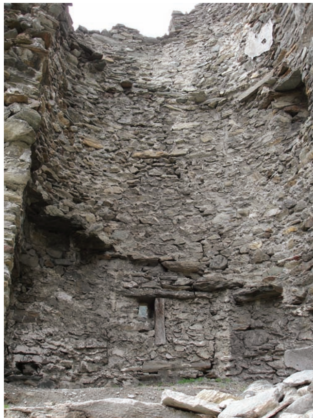
18. Tracce della scala elicoidale. (S.E. Zanelli)
