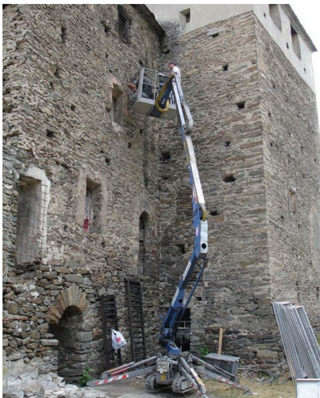
5. Fase di prelevamento dei campioni per le analisi dendrocronologiche. (M. Cortelazzo)
