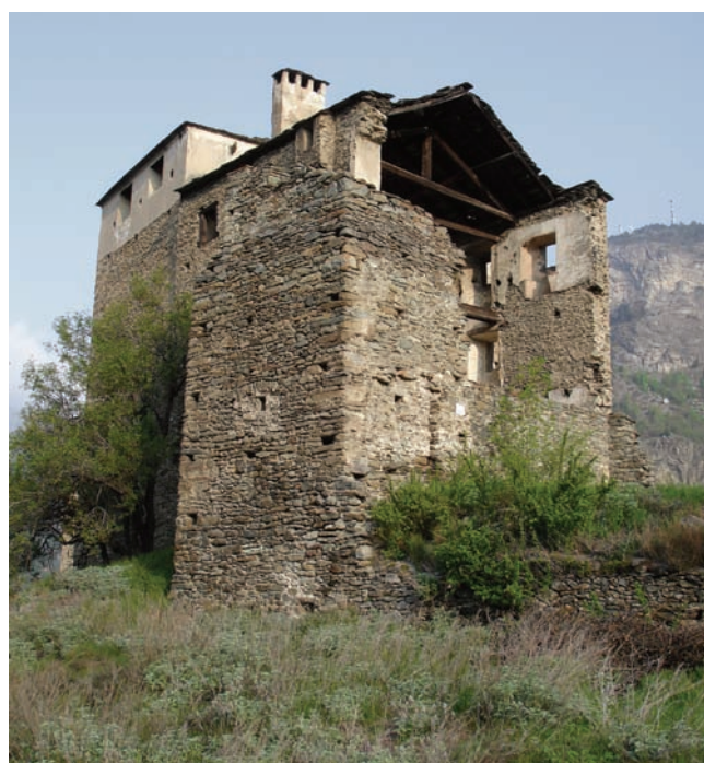
3. In primo piano la torre scalare addossata alle strutture del castello prima dell'avvio dei lavori. (M. Cortelazzo)
