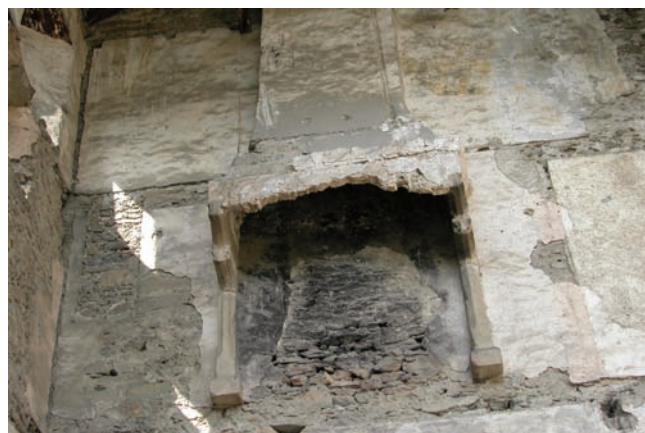
11. Il camino attualmente sospeso nel vuoto. (S.E. Zanelli)
