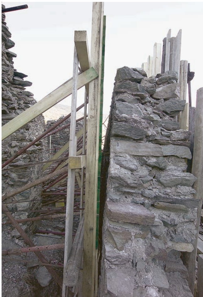
3. Lavori di raddrizzamento del muro sud. (S.E. Zanelli)
