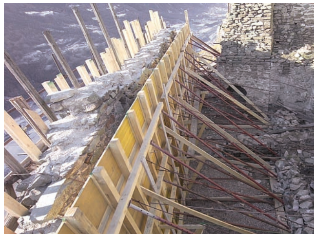
4. Lavori di raddrizzamento del muro sud. (S.E. Zanelli)
