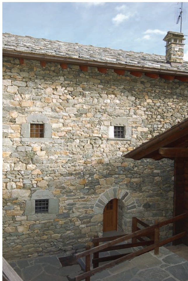
1. Allein, hameau Ayez. Détail d'une des façades après les travaux de restauration. (C. Avantey)
