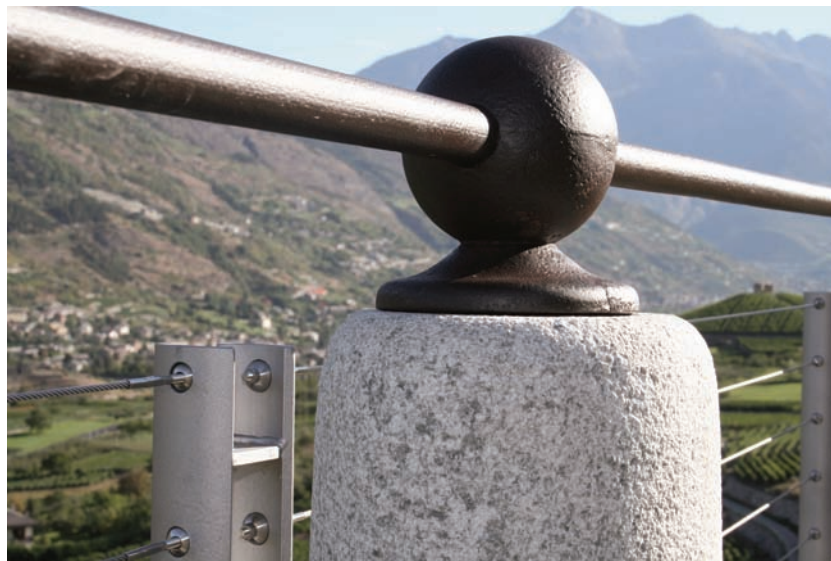
3. Particolare della nuova recinzione e delle bocce restaurate. (A. Novel)
