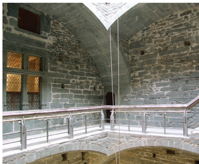
2. Veduta del primo piano dopo la sabbatura. (M. Pesciarelli)
