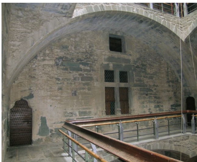
1. Veduta del primo piano prima della sabbatura. (M. Pesciarelli)
