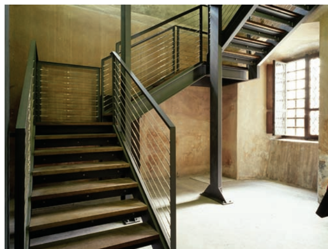
8. Torre ovest. Nuova scala di accesso ai piani primo e secondo. (D. Mazzoli)
