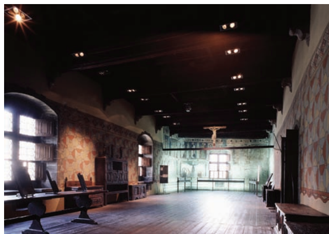
5. Piano primo. La sala della cappella dopo l'intervento. (D. Mazzoli)
