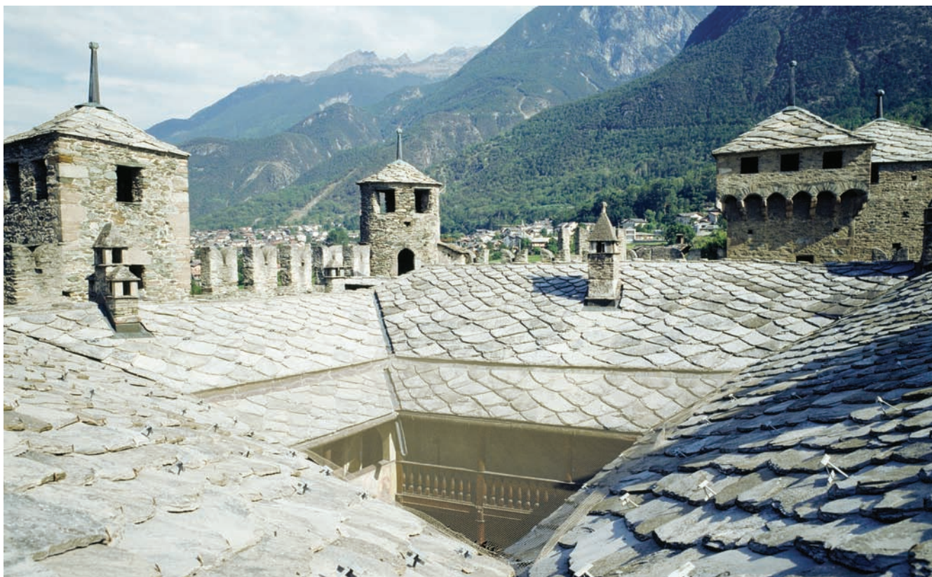
6. Tetto. L'apertura sul cortile interno dopo l'installazione della rete antivolatili. (D. Mazzoli)
