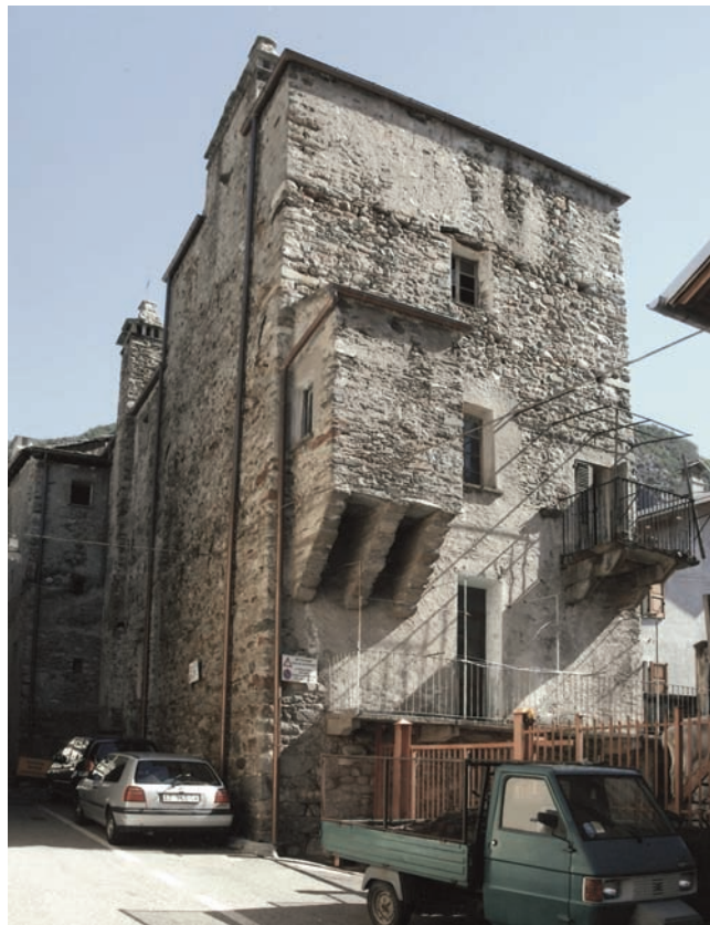
2. Vista sul complesso monumentale dalla via del borgo. (Studio Architettura)
