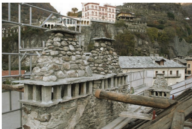
3 - 4. Particolare del tetto della torre e dei camini durante i lavori. (Studio Architettura)
