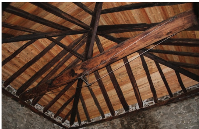
6. Particolare della travatura consolidata del tetto della torre. (Studio Architettura)
