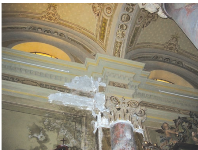
4. Interno della chiesa parrocchiale. Il degrado del capitello della parasta della navata sinistra. (M. Lévêque)
