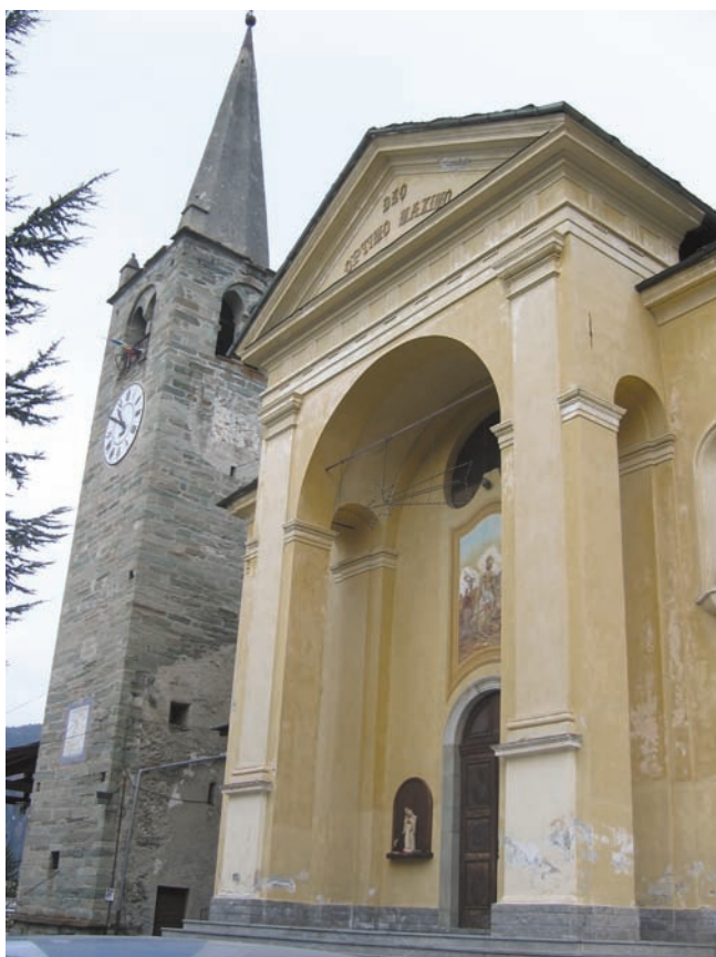
1. Fronte sud della chiesa parrocchiale. (M. Lévêque)
