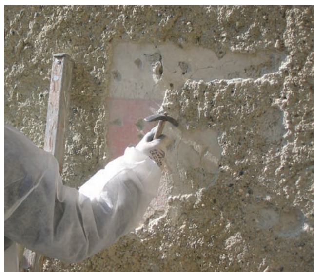
2. Esterno della Chapelle des blancs. L'indagine stratigrafica evidenzia tracce di decorazioni non superficiali. (M. Lévêque)
