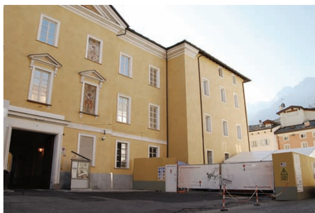
2. Aoste, place Roncas, chantier 2007. (Akbet S.r.l.)
