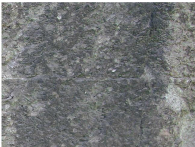
22. Deposito superficiale coerente. (A. Idone)
