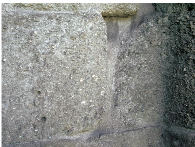
16. Malta di chiusura dei giunti tra i conci. (A. Idone)
