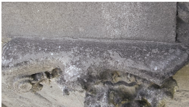
18. Malta con funzione di copertina. (A. Idone)
