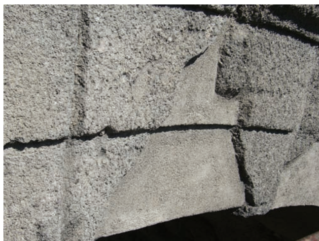
17. Malta di riempimento delle lacune. (A. Idone)
