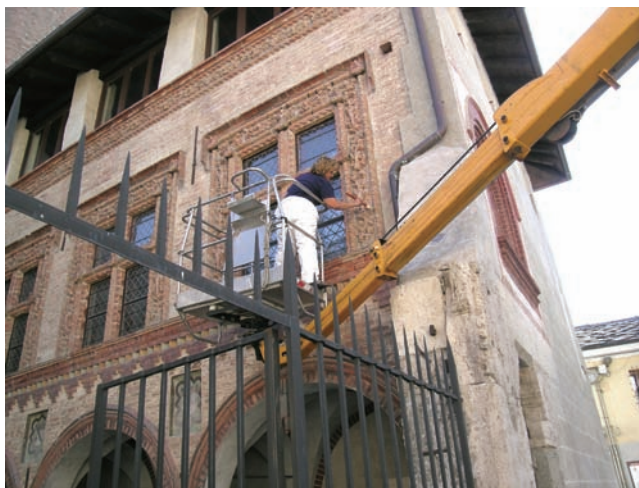
2. Finestra con fregi lato ovest. Intervento di asportazione del particolato atmosferico mediante l'uso di una piattaforma mobile. (P. Longo Cantisano)
