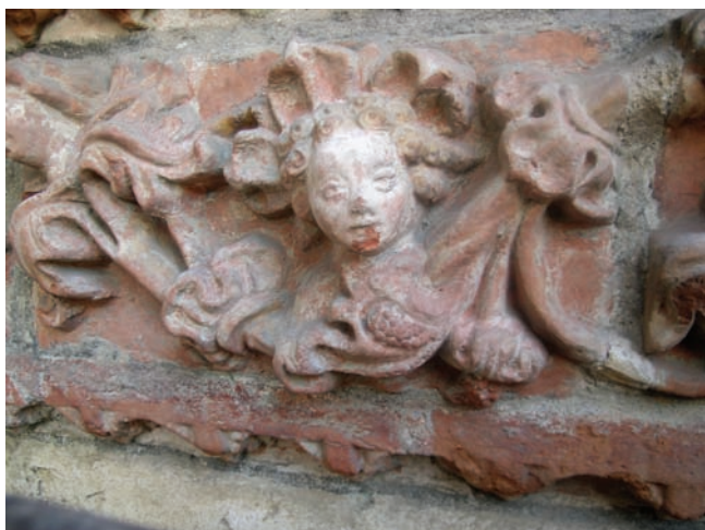
3. Fregio, particolare di una testina. Dettaglio con perdita del materiale costitutivo. (P. Longo Cantisano)
