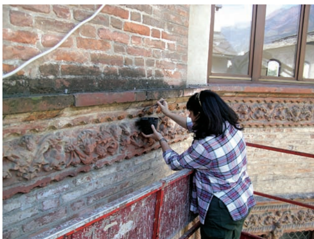
5. Parete della torre campanaria, fregio e marcapiano. Operazione di disinfezione della parete dai licheni mediante applicazione di biocidi. (P. Longo Cantisano)
