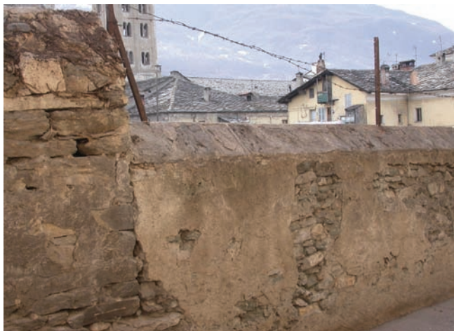
3. Le mur de la prévôté en 2007 après que le lierre a été coupé. (R. Dal Tio)
