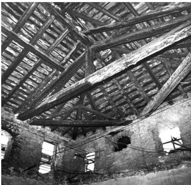
3. Vista della porzione interna alta prima dell'intervento del 1982. (T. De Tommaso)
