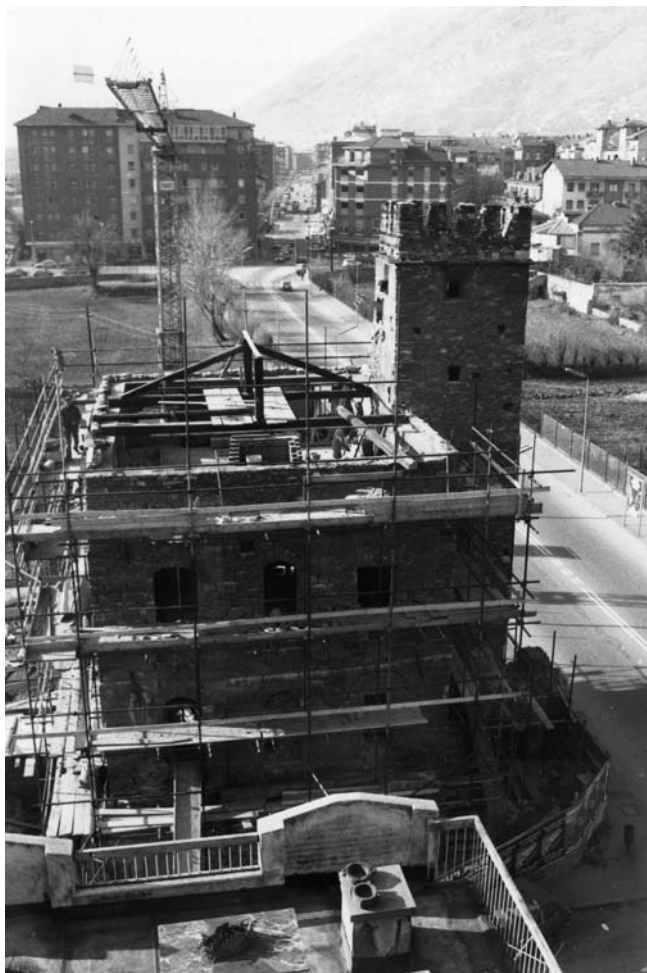
6. Lavori di rifacimento della copertura durante l'intervento del 1982. (A. Sergi)
