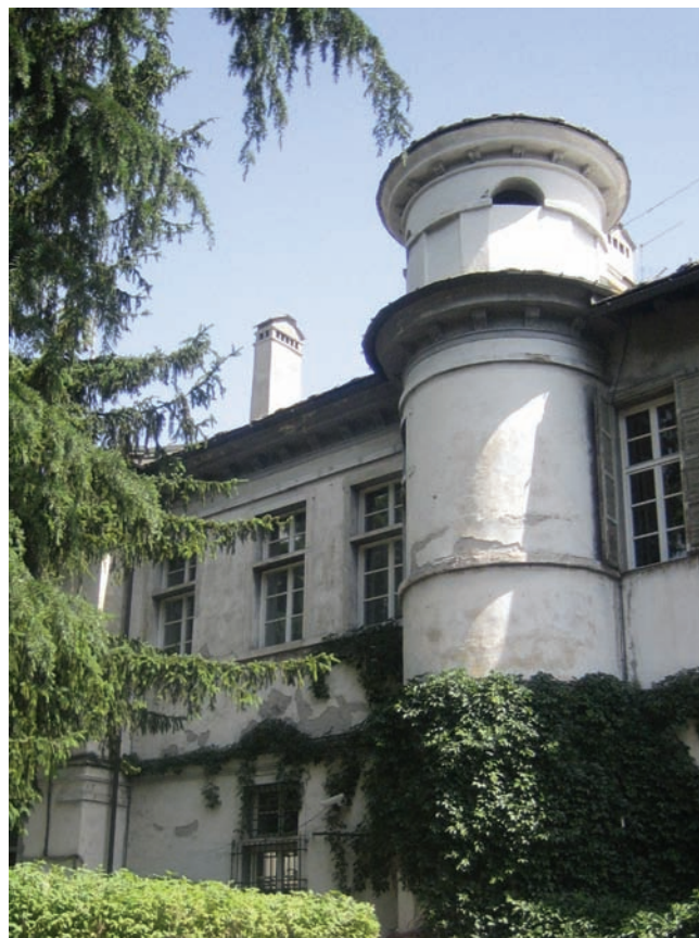
3. Il prospetto retrostante sul cortile. (N. Morise)
