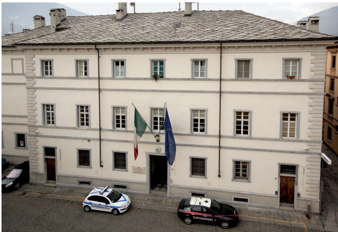
2. Palazzo Roncas: prospetto est. (P. Fioravanti)
