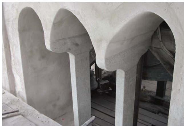
5. Particolare di due colonnine sostituite delle trifore. (S. Togni)
