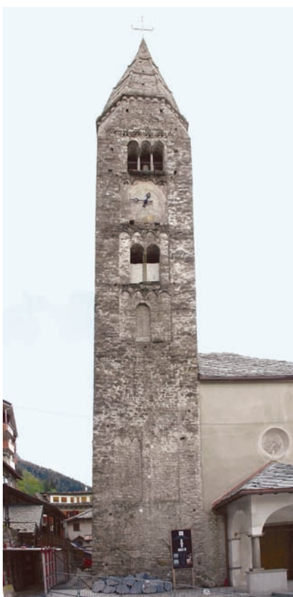
1. Vista del campanile prima del restauro. (S. Togni)
