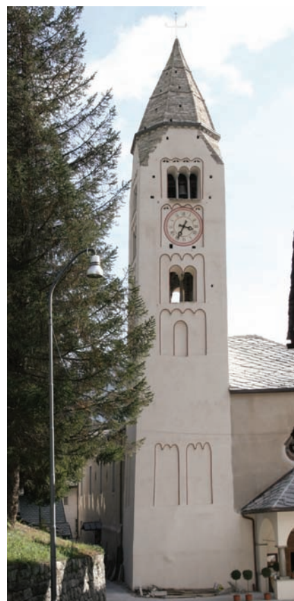
2. Vista del campanile dopo il restauro eseguito nell'estate 2007. (D. Centelli)
