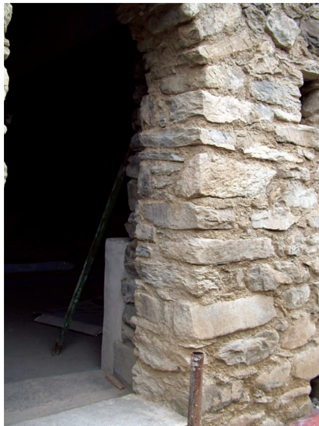
4. Ripristino della continuità della superficie e dell'uniformità cromatica. (M. Monegato)
