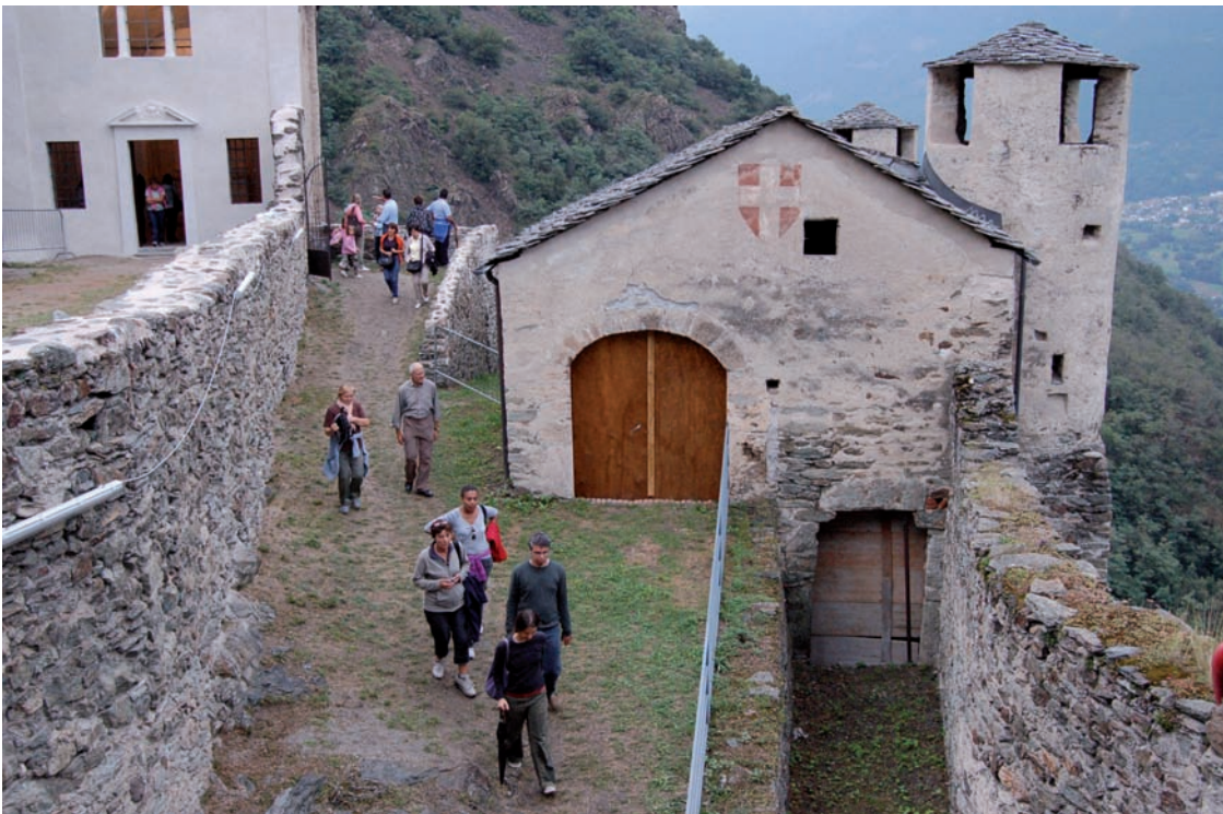
1. Châteaux ouverts, Quart . (P. Fioravanti)
