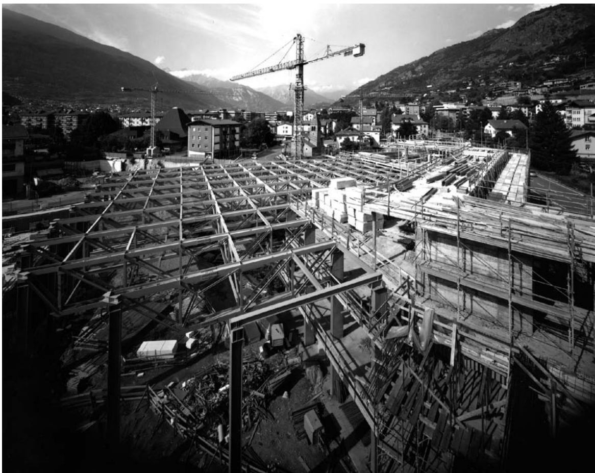
4. L'Aire mégalithique de Saint-Martin-de-Corléans. Le chantier en construction. (D. Cesare)
