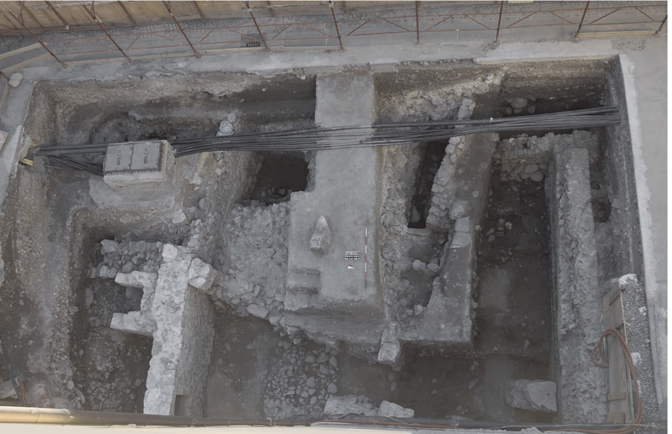
4. Veduta dall'alto del lato occidentale dell'edificio meridionale con i basamenti dei pilastri centrali. (C. De Davide)
