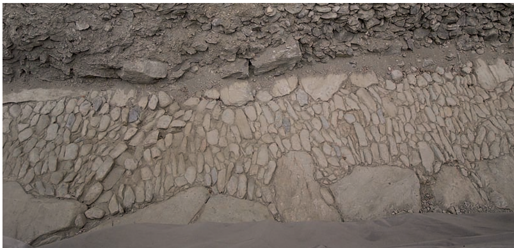
5. Selciato stradale con particolare della canaletta per la raccolta e lo smaltimento delle acque meteoriche. (S.E. Zanelli)
