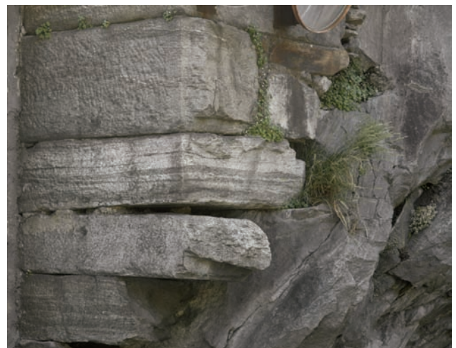
12. Particolare dell'opera quadrata con bugne. (L. Caserta)
