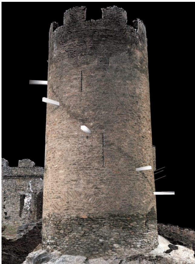
8. Scansione laser con posizionamento dei travicelli dell'impalcato. (L. Bornaz - SIR S.r.l. Aosta)
