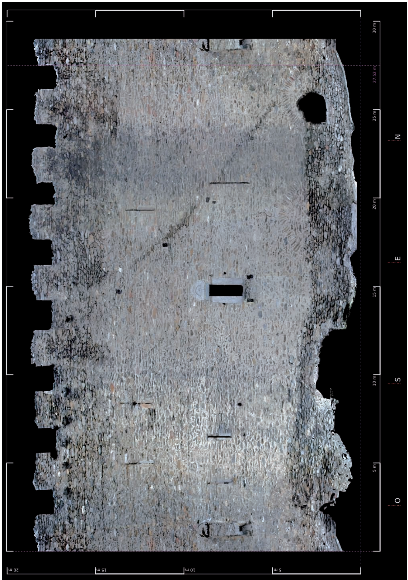
7. Ortofoto di precisione, solida, cilindrica della torre. (L. Bornacq - SIR S.r.l. Aosta)
