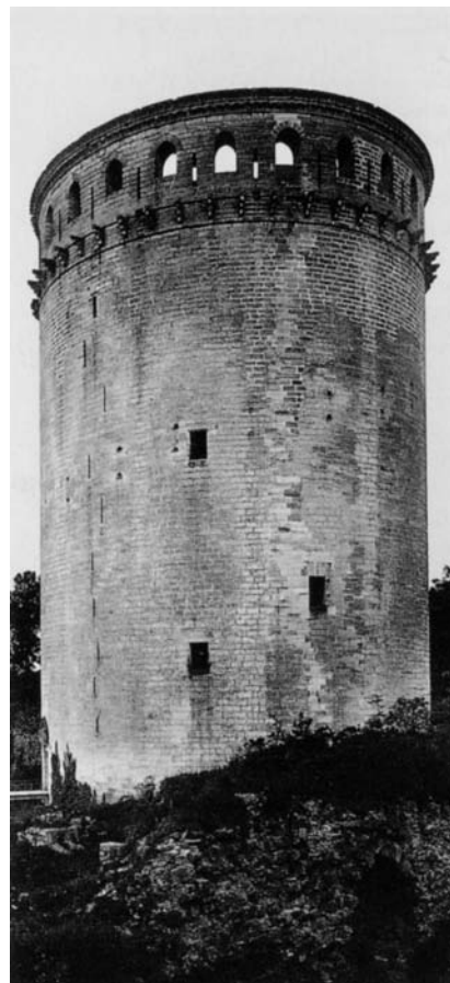
14. Torre di Concy-le-Château (Aisne - Picardie). Buche pontai relative ad un impalcato elicoidale a doppio travicello. Immagine ripresa prima della distruzione della torre avvenuta nel 1917. (Tratta da D. DE RAEMY, Châteaux, donjons et grandes tours dans les Etats de Savoie (1230-1330). Un modèle: le château d'Yverdon, in "Cabiers d'archéologie romande", 98 e 99, Lausanne 2004, p. 136, fig. 189)
