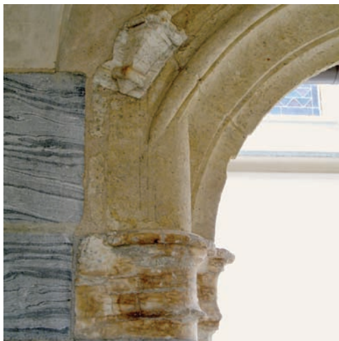
5. Peduccio in gesso cristallino (contrafforte nord-est). (R. Perinetti)
