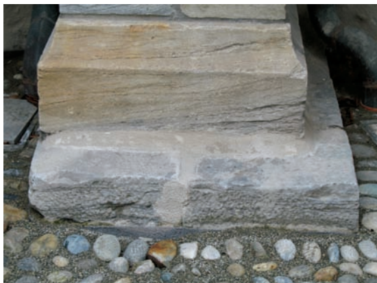
10. Base contrafforte angolare nord-ovest. (R. Perinetti)
