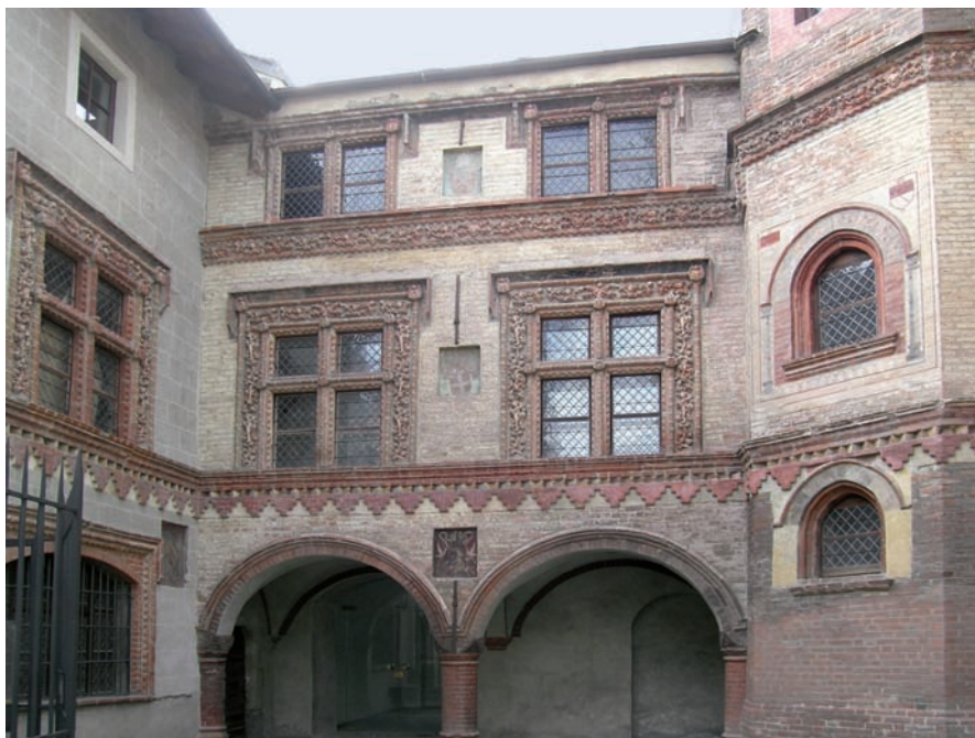
1. Veduta d'insieme della facciata del Priorato su cui insistono le finestre della cappella di San Giorgio. (P. Longo Cantisano)
