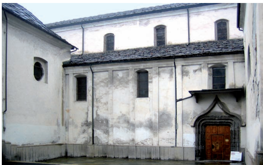
1. Fronte sud prima degli interventi. (N. Morise)
