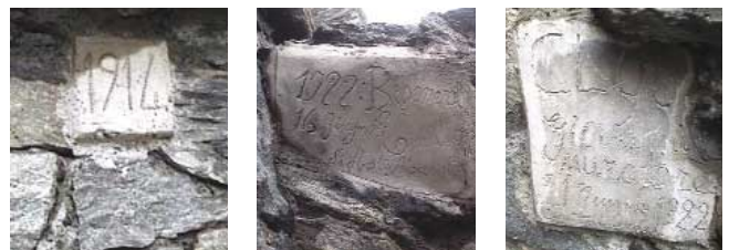
3. Incisioni su placche di legante indicanti le date dei restauri del 1914 e 1922. (M. Cortelazzo)
