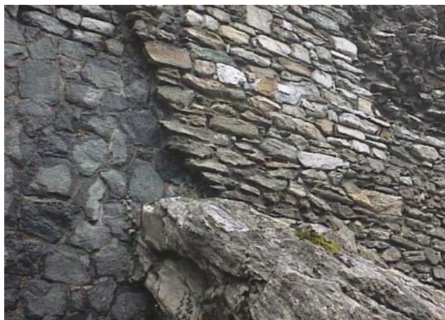
5. Particolare di un restauro (1922) con ciottoli e pietrame disposti in opera a faccia vista. (M. Cortelazzo)
