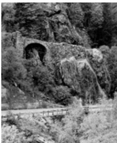
2. Tratto di strada romana oggetto di restauro prima dell'intervento. (L'Image)
