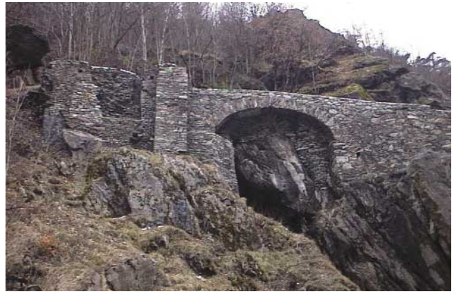
6. Tratto di strada romana dopo l'intervento di consolidamento e restauro. (M. Cortelazzo)
