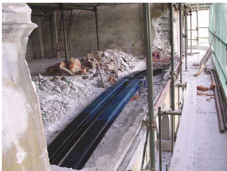
Consolidamento arco zoppo: inserimento trave superiore. (A. Novel)
