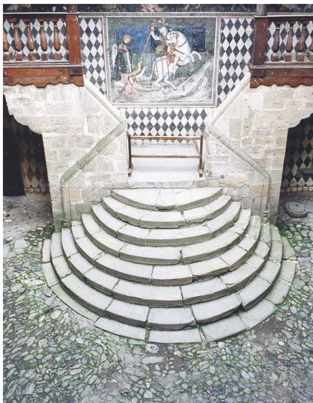
Scalinata corte interna. (P. Fioravanti)
