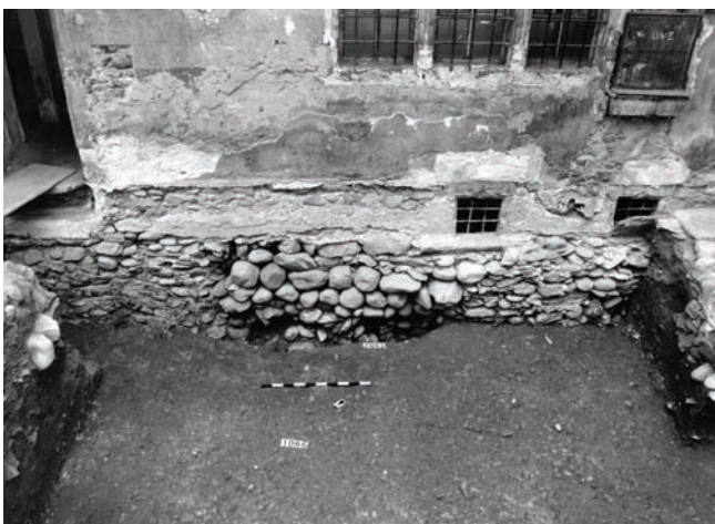
17. Sottomurazione in ciottoli effettuata dall'interno dell'edificio. (S.E. Zanelli)
