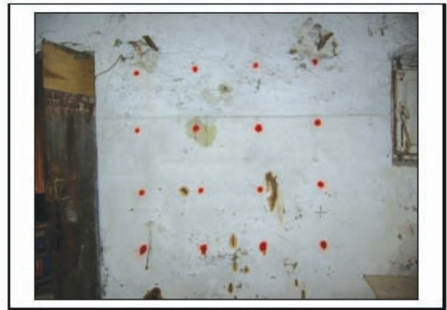
Sonica n. 2 - Parete perimetrale - lato nord
