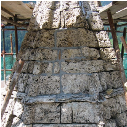
17. Guglia del campanile in fase di restauro. (N. Dufour)
