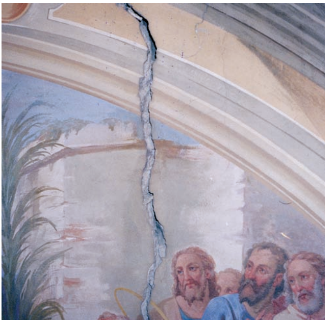
14. Particolare del dissesto della parete nord del coro. (L. Pizzi)
