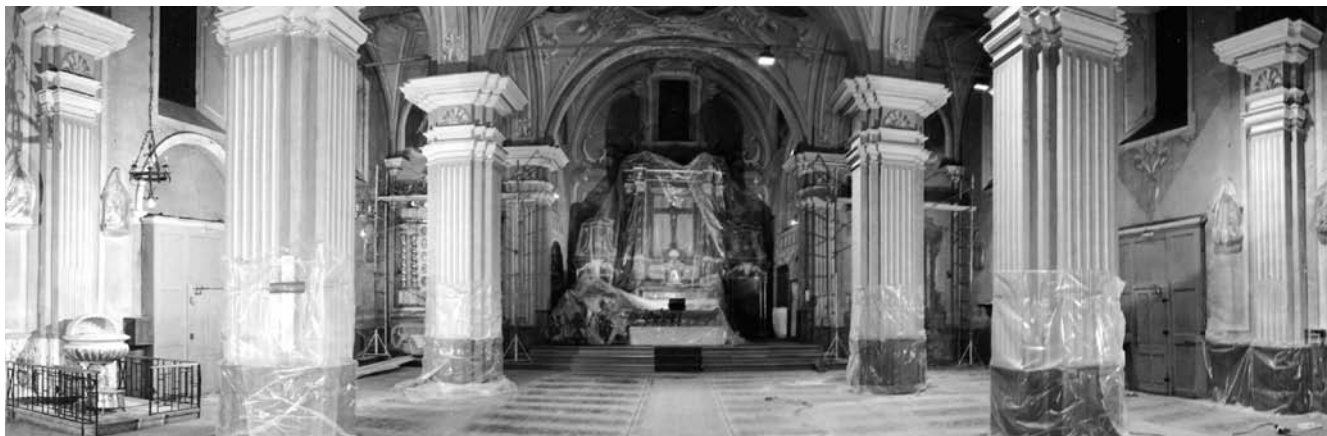
1. Interno della chiesa prima dello scavo. (FT Studio)
