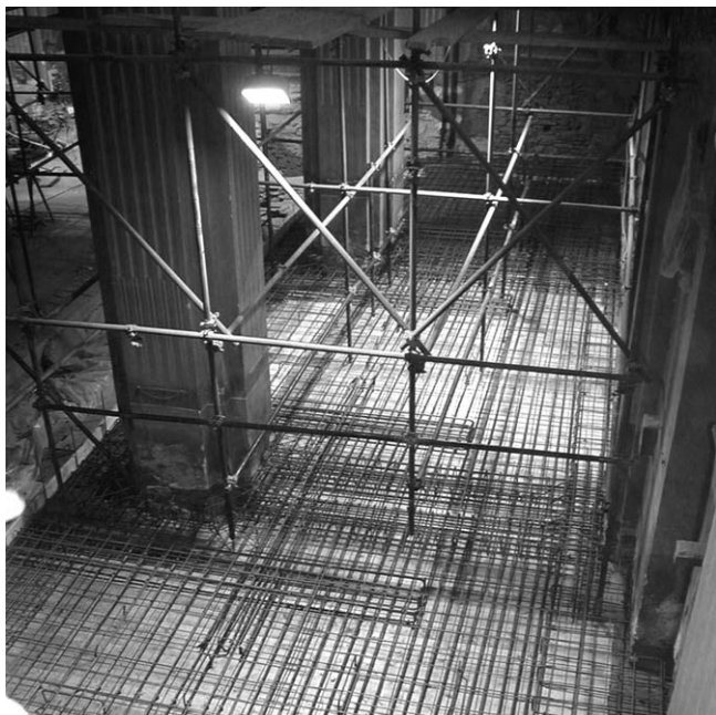
11. Fase di realizzazione della soletta su reperti archeologici. (C. Cometto)
