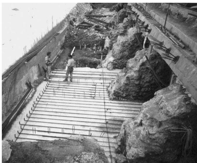
12. Consolidamento piazza antistante la chiesa. (C. Cometto)
