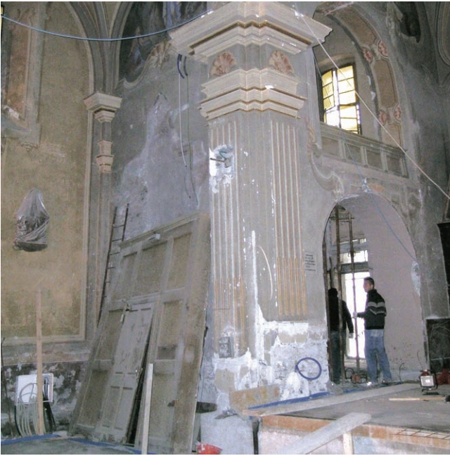
13. Zona a nord dell'altare durante i lavori di restauro interno. (N. Dufour)
