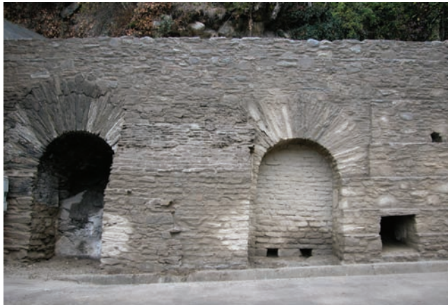
10. Rilievo (G. Abrardi) e fotografia (R. Perinetti) del sistema stradale di II fase, composto dalle due arcate e da un contrafforte intermedio.
