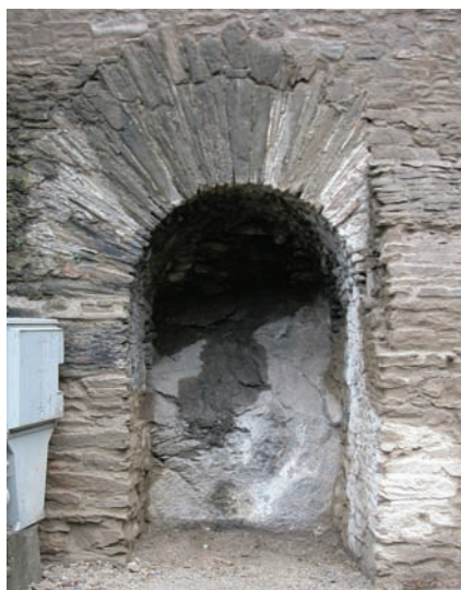
5. Rilievo (G. Abrardi) e fotografia (R. Perinetti) della prima arcata.
