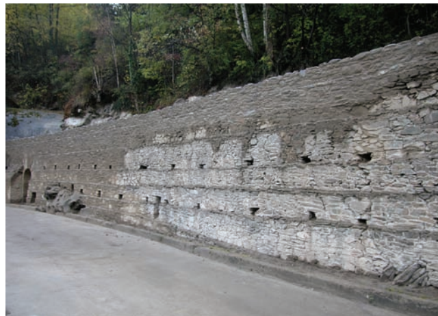
13. Tratto di cortina muraria, dopo l'intervento di restauro. (R. Perinetti)
