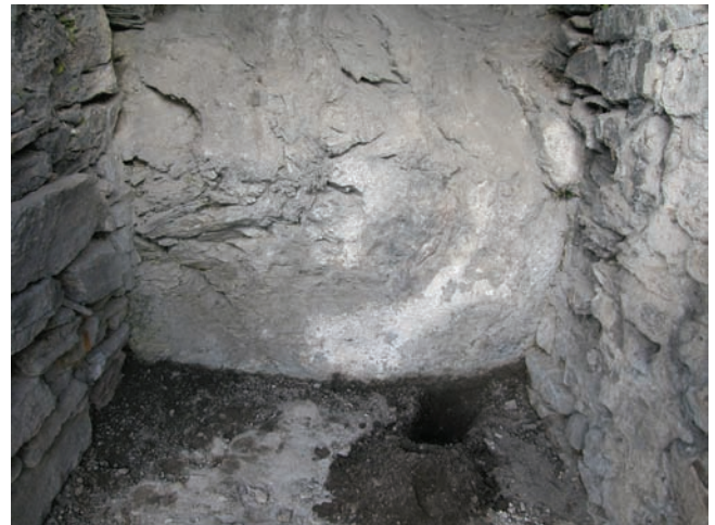
9. Particolare del taglio nella roccia in corrispondenza della prima arcata. (R. Perinetti)
