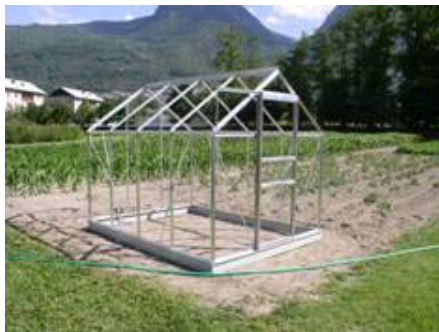
La serra in fase di costruzione
