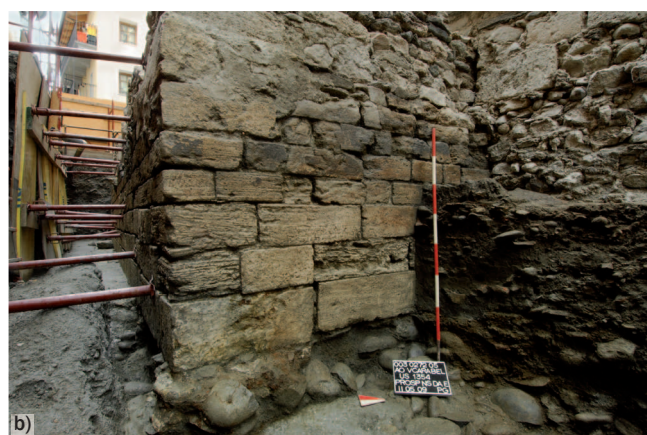
6. L'angolo sud-ovest originario, fase I (a), e i rifacimenti dell'angolo sud-est, fase II (b), della torre ovest della Porta . (P. Gabriele)
