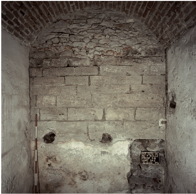
4. Il paramento orientale della torre ovest della Porta nei sotterranei di Palazzo Rolle. (P. Gabriele)
