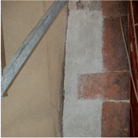
4. Operazione di recupero del disegno a catena dei conci della ghimberga dopo la pulitura e l'intervento di restauro. (S. Pulga)
