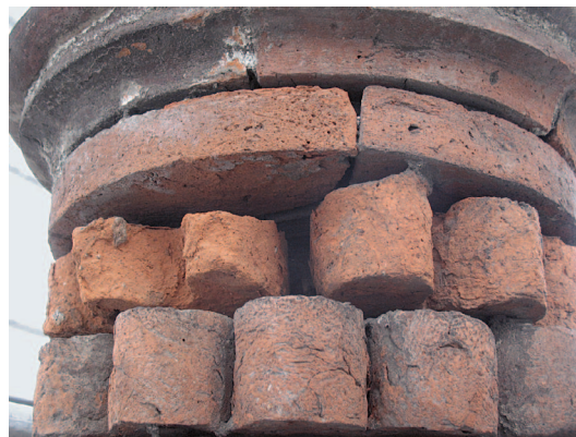
1. Esempio di decoesione e di degrado dei conci in cotto dei pinnacoli. (S. Pulga)
