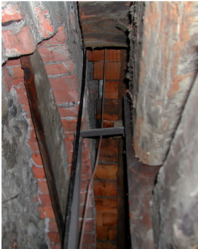
3. Lo stretto spazio tra la capriata e l'arco di mattoni. (S. Russo)
