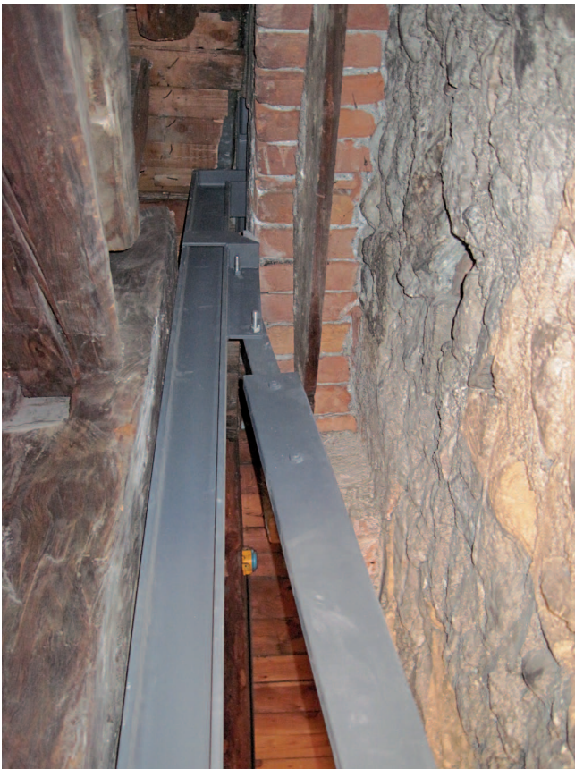
4. Il montante in opera tra la capriata e l'arco di mattoni. (R. Ferrod)
