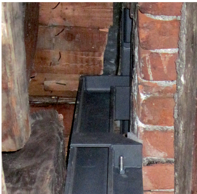
7. Particolare testa del montante inserita nella nicchia. (R. Ferrod)
