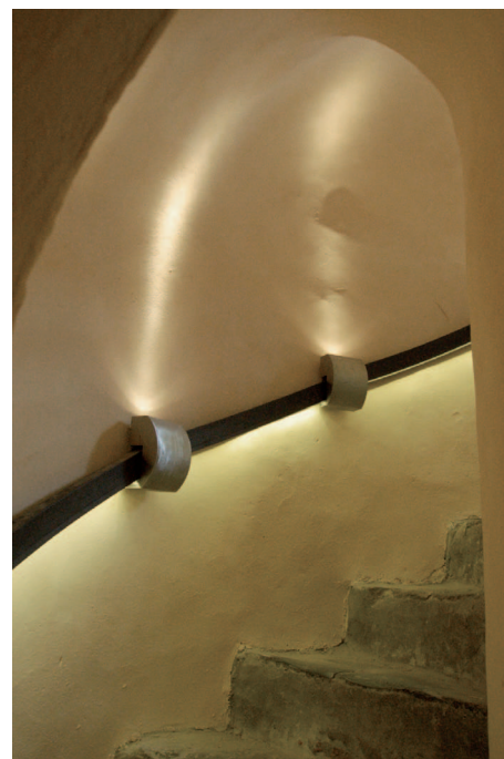
7. Scala di salita al sottotetto: illuminazione dopo l'intervento. (S. Togni)
