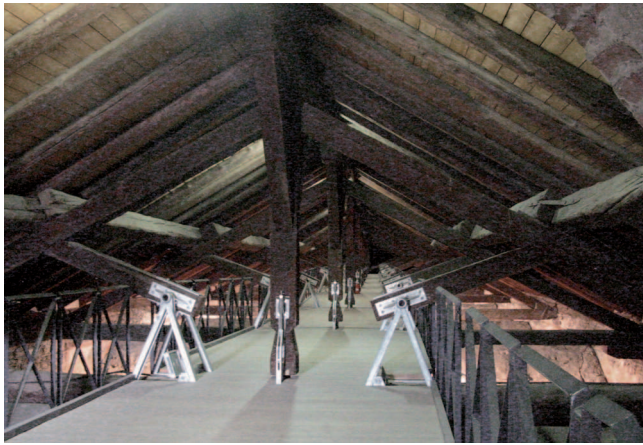
11. Sottotetto centrale: vista prima della sostituzione dell'illuminazione. (A. Novel)
