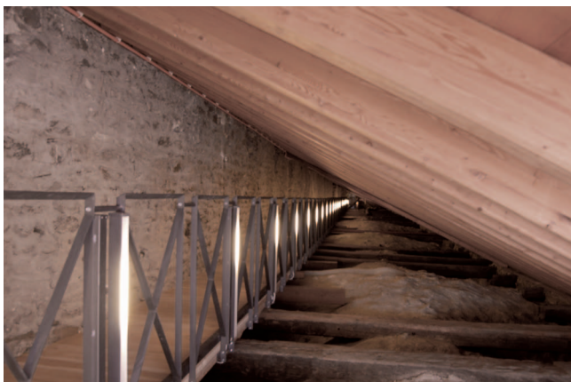
10. Passerella di visita nel sottotetto laterale nord dopo l'intervento. (A. Novel)
