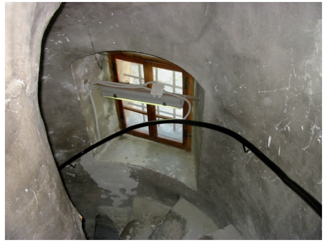
6. Scala di salita al sottotetto: illuminazione prima dell'intervento. (S. Togni)
