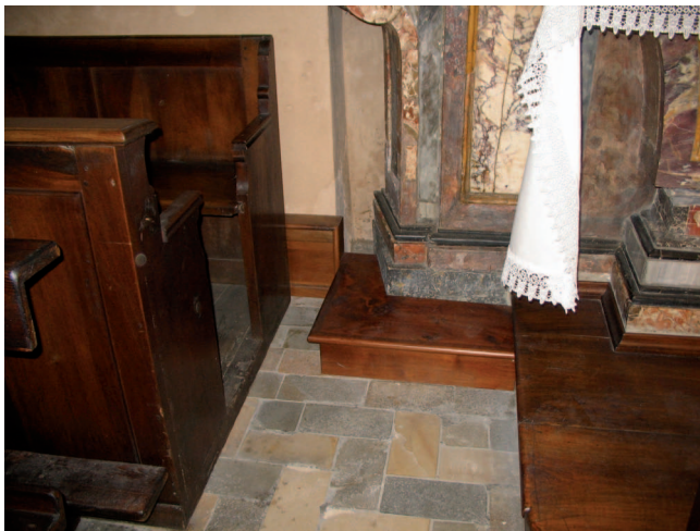
3. Particolare finitura della canalina a parete rivestita in legno. (S. Togni)
