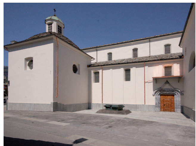
18. Facciata sud dopo l'intervento di manutenzione e il posizionamento del cenotafio di Cox. (A. Novel)
