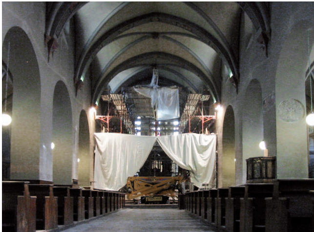
17. Particolare ponteggio nella zona del coro. (A. Novel)
