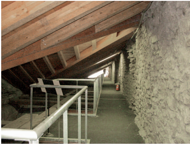
8. Passerella di visita nel sottotetto laterale nord prima dell'intervento. (S. Togni)
