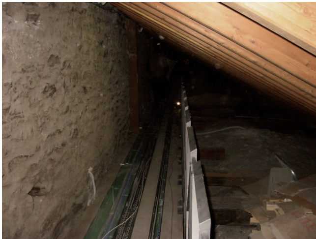
9. Passerella di visita nel sottotetto laterale nord durante l'intervento. (S. Togni)
