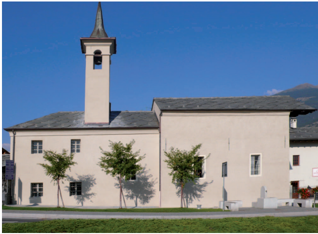
2. Interventi completati sul prospetto orientale. (D. Costantini)
