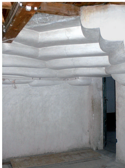
4. Sala del cucito: i mensoloni di sostegno di una delle torri. (F. Lupo)
