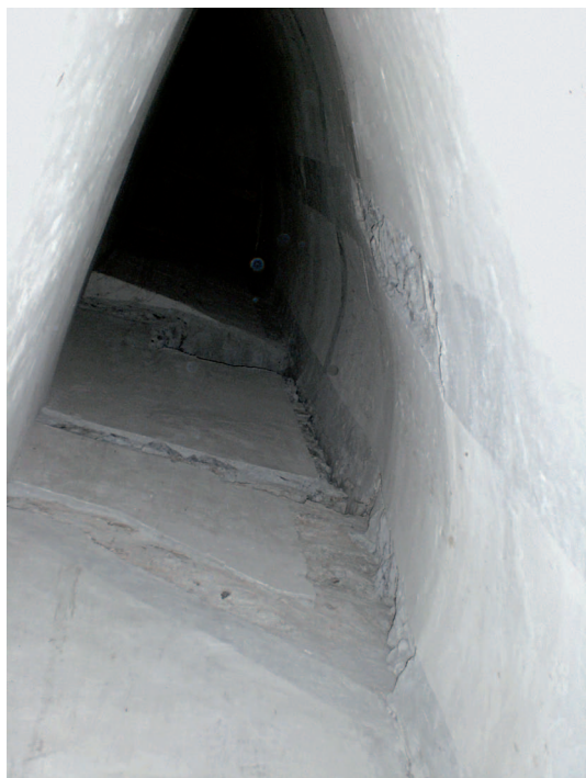
2. Cavedio lungo lo scalone aulico: l'innesto delle torri circolari sul mastio originario. (F. Lupo)
