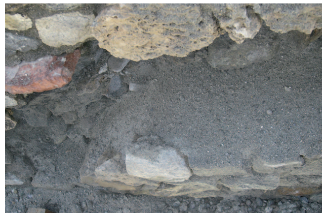
9b. L'intervento di ancoraggio della stessa porzione di paramento mostrata in fig. 9a, viene completato mediante la chiusura della fessurazione con una malta apposta a carattere riempitivo ed adesivo, che mascherà anche le barre in vetroresina precedentemente applicate. (D. Capaldini - COO.BE.C.)
