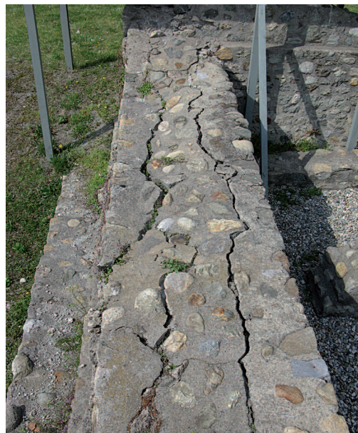
2. Ampie fratture sulla cresta di un muro "a sacco" ricostruito in ciottoli e cemento nel corso degli interventi manutentivi del secolo scorso. (C. Pedeli)
