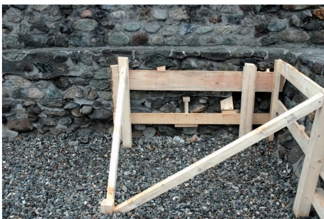
5. Esempio di puntellatura passiva in cui si intravedono alcune mensole che si inseriscono all'interno della struttura muraria. (D. Capaldini - COO.BE.C.)
