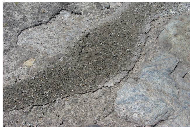
6b. Sigillatura provvisoria di emergenza, in mastice da vetraio. La foto mostra la sigillatura finita, con sabbia di fiume pressata nella pasta di mastice. Sui bordi della sigillatura s'intravede il lembo del film di Polietilene che funge da interfaccia. (C. Pedeli)
