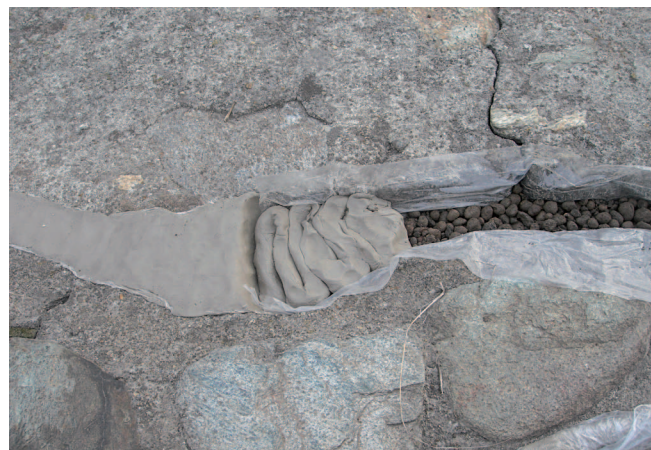
6a. Preparazione di una sigillatura in mastice da vetraio. Sull'ultimo livello della cavità viene steso un film di Polietilene (interfaccia), successivamente riempito di argilla espansa in perle; infine la frattura viene sigillata con mastice da vetraio puro, grigio. (D. Capaldini - COO.BE.C.)
