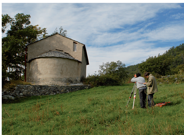
4. Inquadramento topografico dell'intero manufatto al fine di legare spazialmente il rilievo dell'interno con quello dell'esterno. (P. Salonia)
