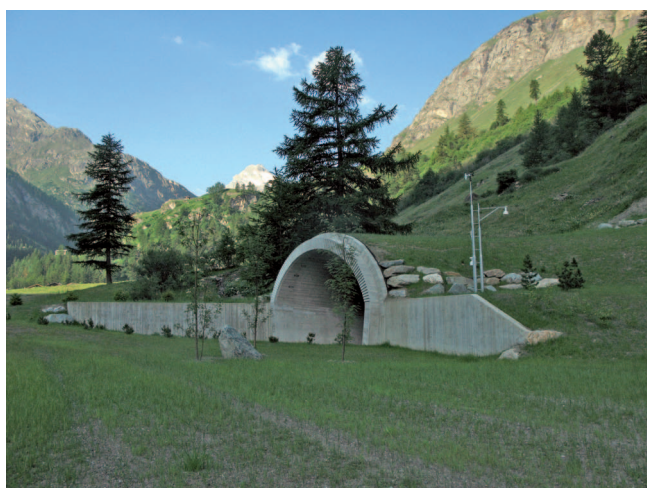
9. Rhêmes-Notre-Dame. Loc. Thumel, centrale idroelettrica. (S. Pariset)
