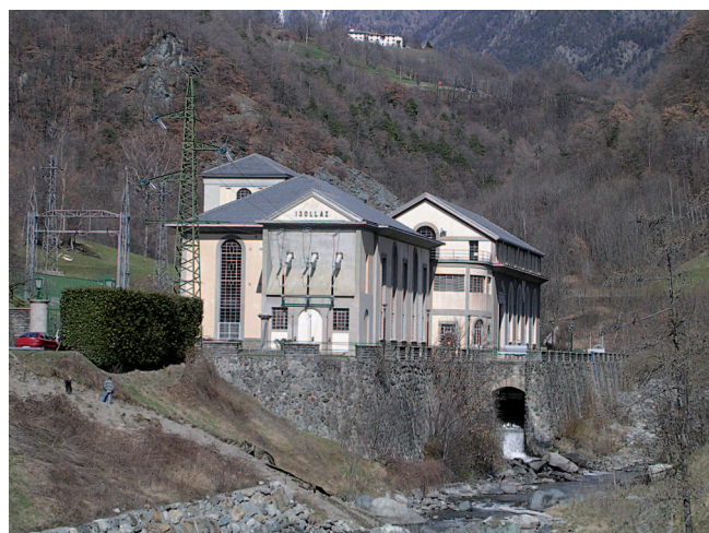
7. Challand-Saint-Victor. Loc. Isollaz, centrale idroelettrica. (D. Martinet)
