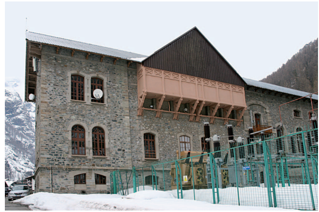
4. Gressoney-La-Trinité. Loc. Obre Eselbode, centrale idroelettrica. (D. Centelli)
