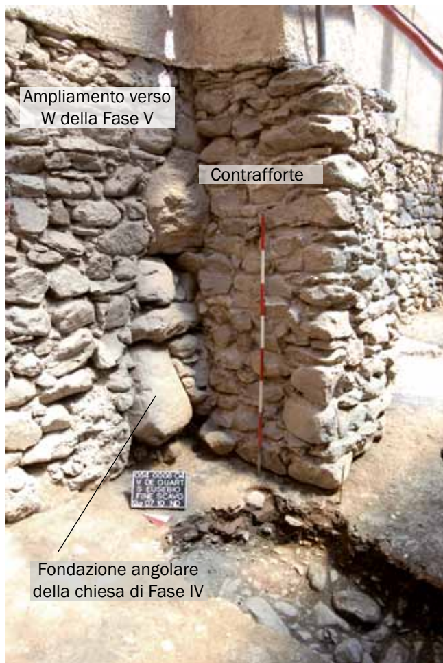
10. Ampliamento settecentesco verso ovest della chiesa di fase IV. (N. Drusovic, elaborazione D. Sepio)
