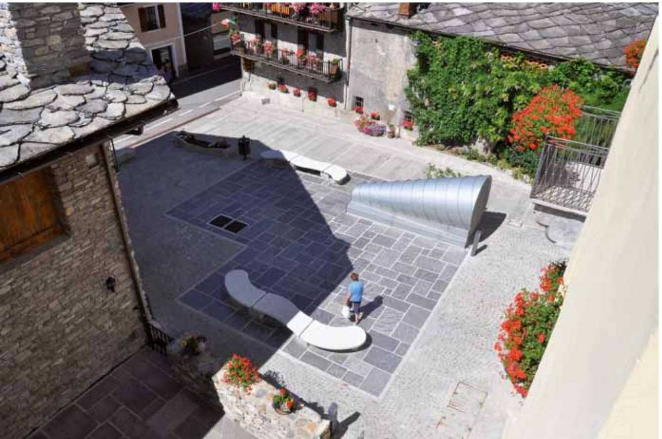
9. Vista dall'alto della piazza a lavori conclusi. (Archivi Soprintendenza per i beni e le attività culturali)
