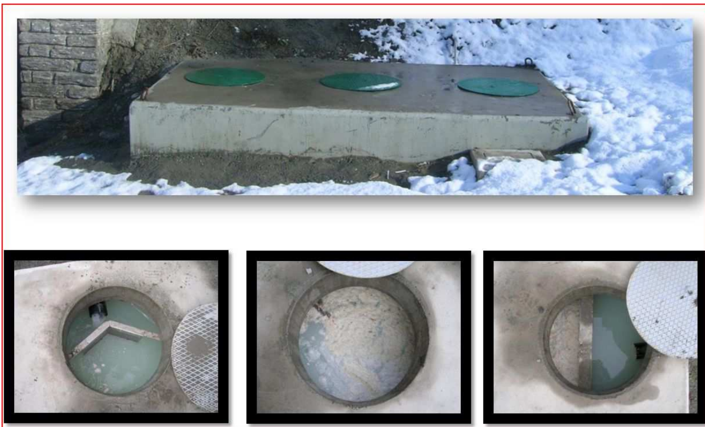
dégraisseur avec le détail des trois cloisons
