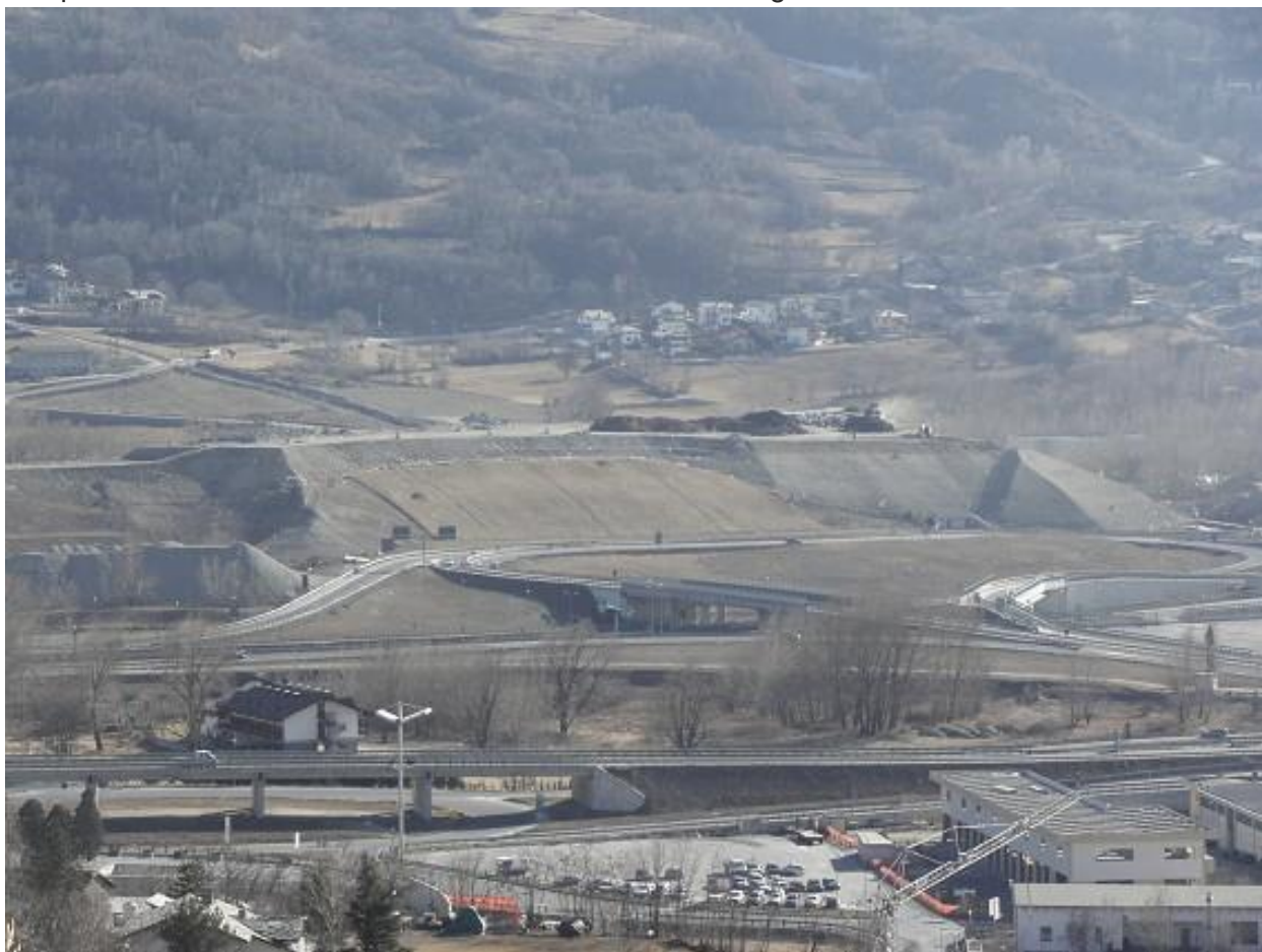
Veduta frontale della discarica di Brissogne
