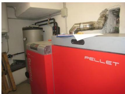
*Caldaia a pellet da 15 KW (Ca4)*
