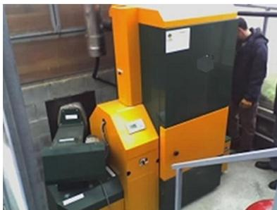
*Caldaia a cippato da 100 KW (Ca1)*
