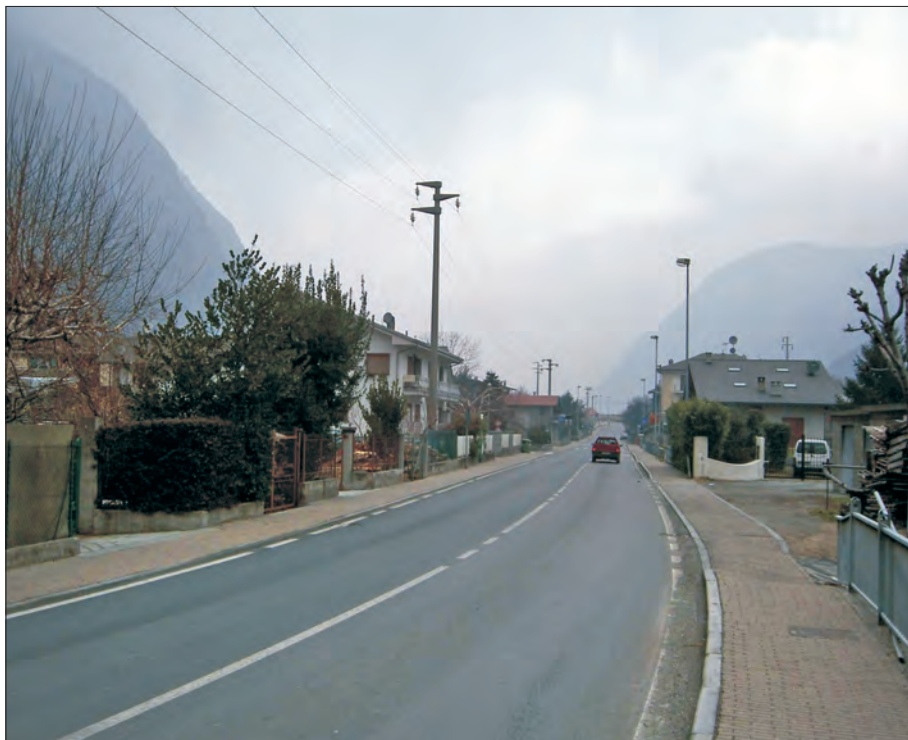
Nelle immagini di questa pagina, Comune di Hône: intervento di interrimento di elettrodotti di media tensione (2004) - prima e dopo.
