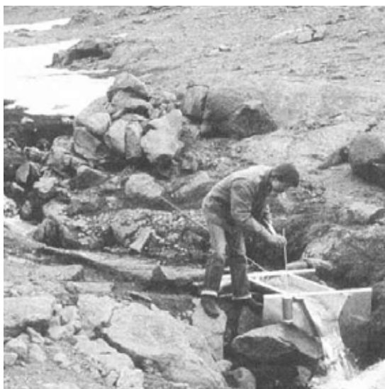
Figura 56 - Realizzazione di misuratore a risalto trasportabile con lamiera metalliche per piccoli corsi d'acqua alpini.
