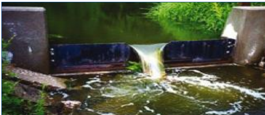
Figura 43 - Stramazzo triangolare in parete sottile in funzione
