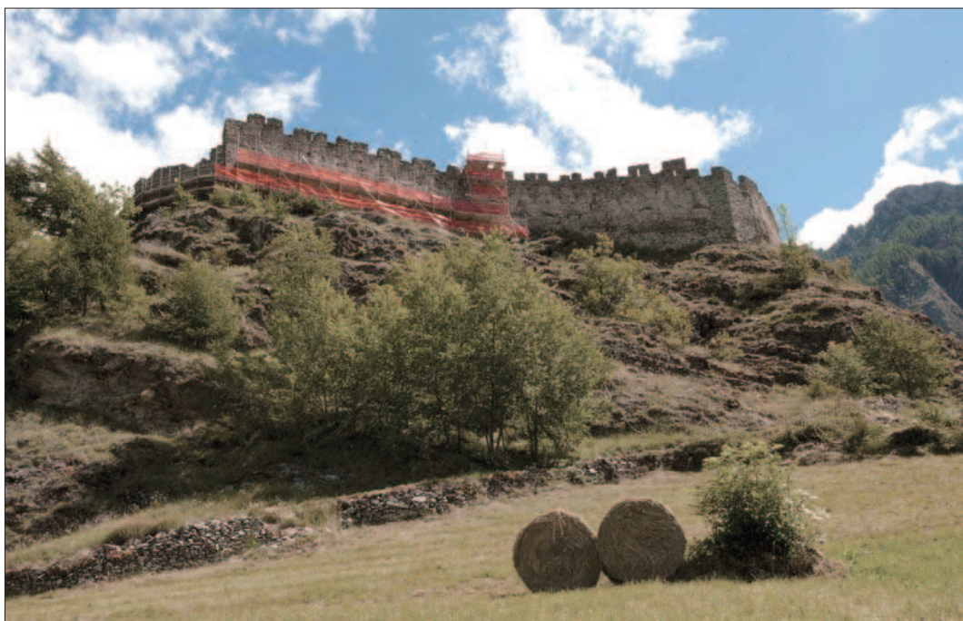
3. Château de Graines, chantier sur l'escarpe méridionale. (G. Crivellari)
