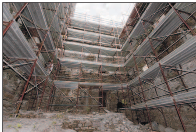
8. Château de Saint-Marcel, les échafaudages pour la mise en sécurité de l'aire de fouilles. (G. Crivellari)
