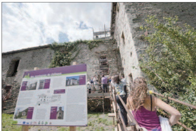
9. Château de Saint-Marcel, la passerelle montée à l'occasion des visites de chantier. (G. Crivellari)
