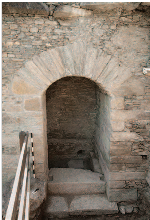
7. Ingresso occidentale al camminamento inferiore. (S.E. Zanelli)
