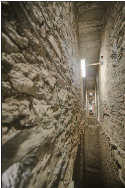
8. Interno del camminamento inferiore dopo lo scavo. (P. Celestia)
