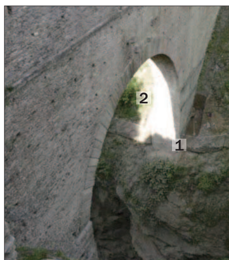
6. Posizionamento dei sondaggi 1 e 2 alla base della spalla occidentale. (S.E. Zanelli)
