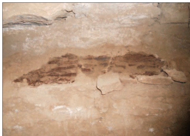
9. Frammento di trave lignea ancora in situ all'interno di uno dei setti ortogonali. (LRD)
