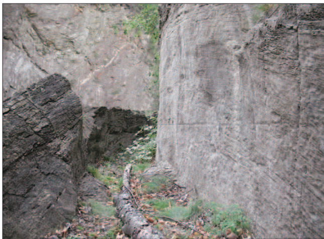
4. Un tratto del canale adduttore ricavato nella roccia a monte di Pont d'Aël. (D. Marquet)
